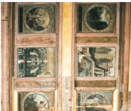
Konsolidierung einer geschädigten Decke durch Behandlung mit einem nanoskaligen SiO 2 -Sol im Rittergut Hof bei Riesa (Foto: Feinchemie Sebnitz GmbH)
